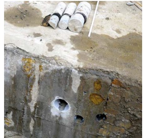
(4) Bauwerksuntersuchungen – Bohrkernentnahme
