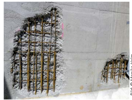
(7) Freigelegte Bewehrung nach der Untergrundvorbereitung
