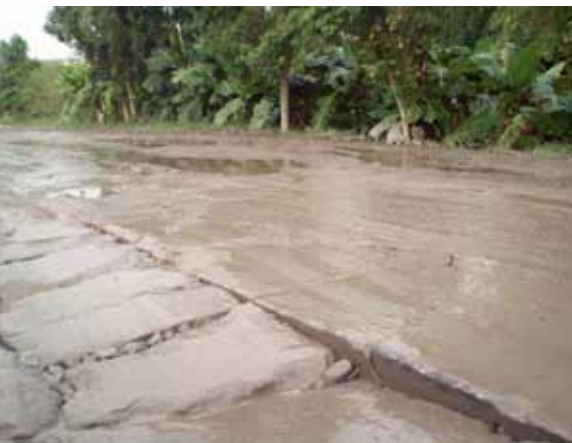
Es gilt, den Betonstraßenbau weiter voran zu treiben, ...
